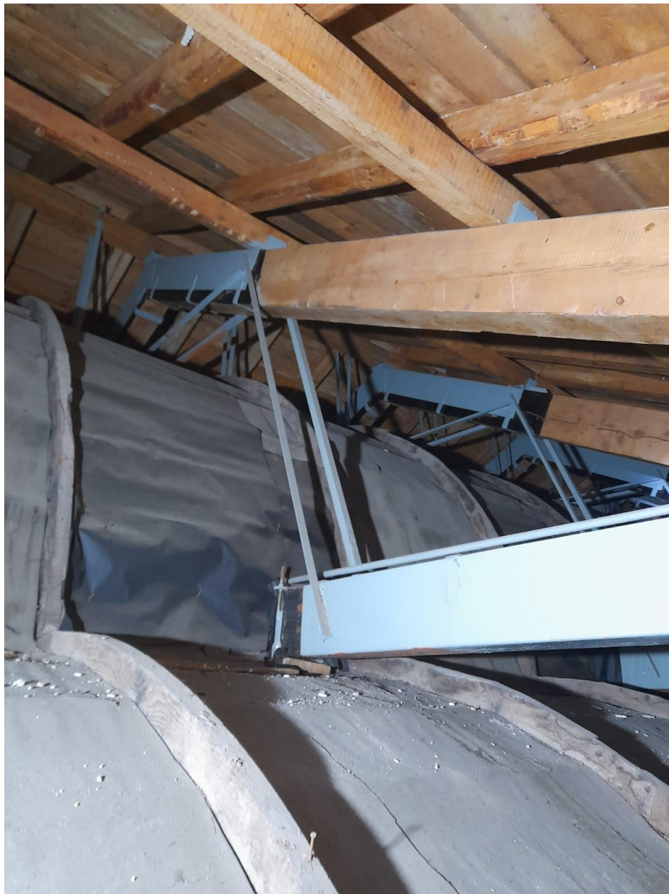
Figure 6. Verona, Basilica of San Zeno Maggiore, attic spaces above the aisled nave. (Source: ADB Architettura e Ingegneria, Verona)
